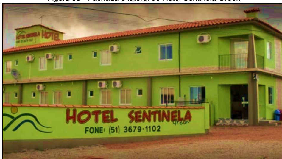
Figura 35 - Fachada e lateral do Hotel Sentinela Green
